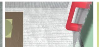
9. Extender una capa fina de cemento cola con la llana de 4 mm.
