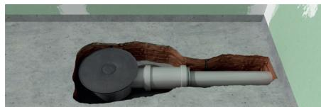
**3. Conectar el sumidero a la tubería y formar las pendientes protegiendo el interior con la tapa gris que después retiraremos.**
