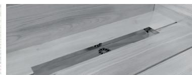
16. Pavimentar el plato y revestir las paredes.
