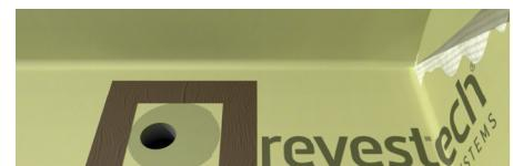
12. Formar las esquinas plegando la lámina. Aplicar también cemento cola en el pliegue de la misma.
